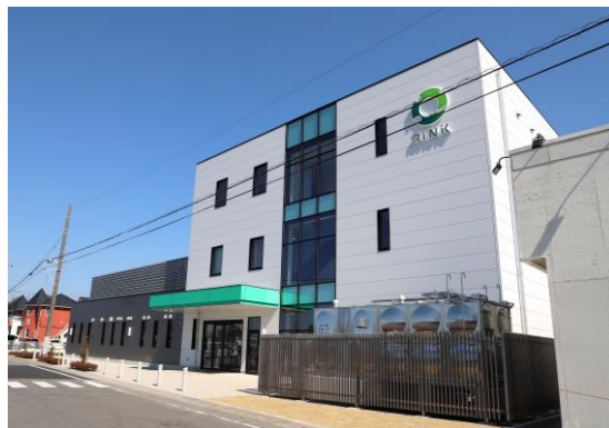
□龍ヶ崎市役所保健福祉棟
