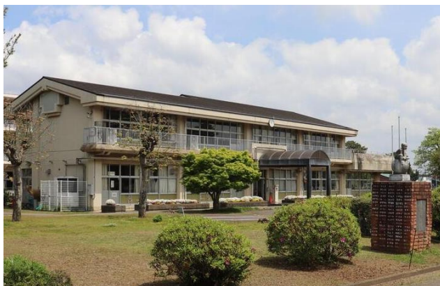
▲龍ヶ崎市立龍ヶ崎小学校の校舎
