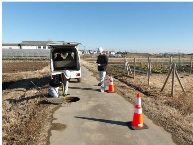
▲市職員による点検の状況
