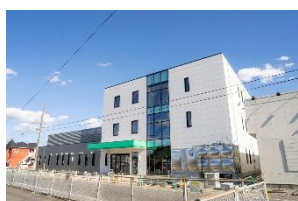
龍ヶ崎市役所保健福祉棟
